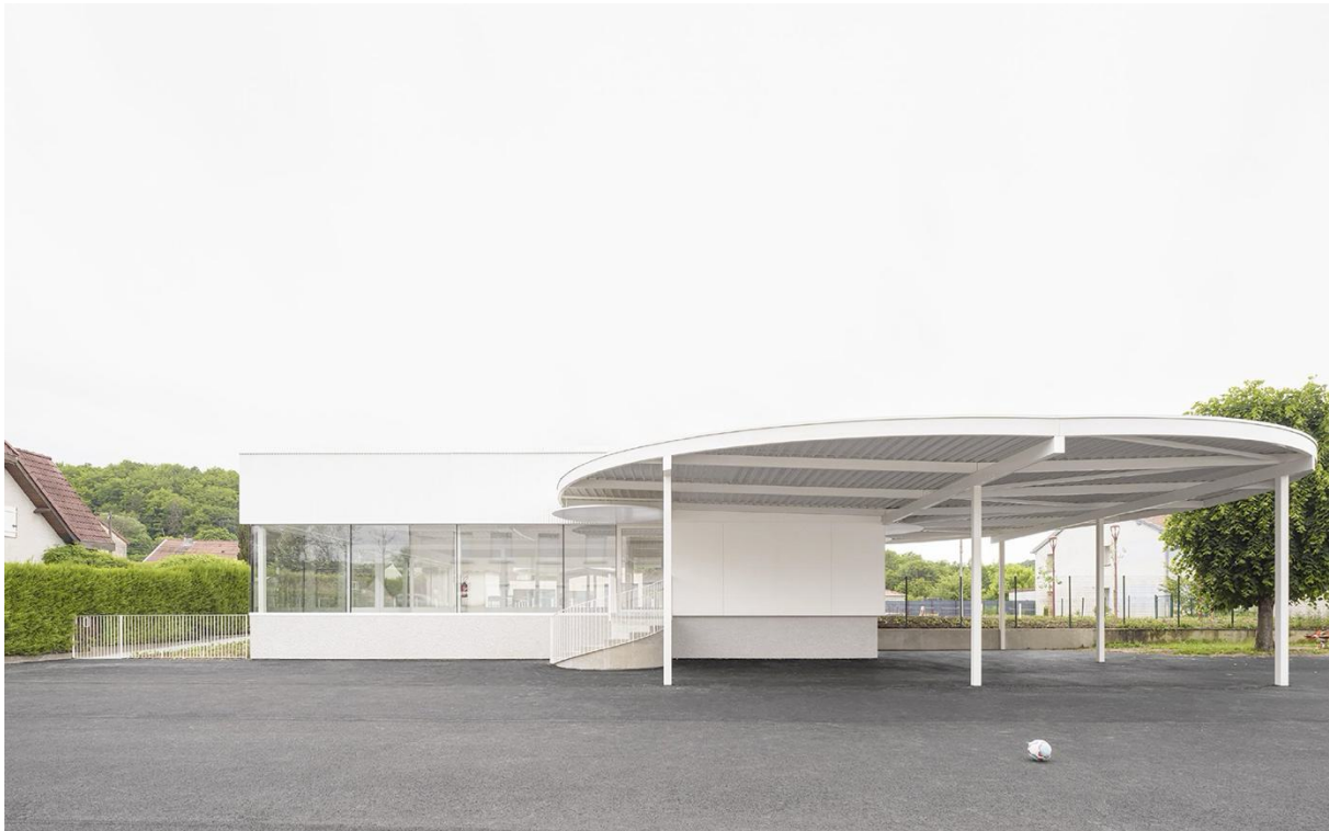
Gens , Station-Service, Médiathèque, Velaines, photo Cervený, 2024, recadrage 8/5 Pur 2026.
